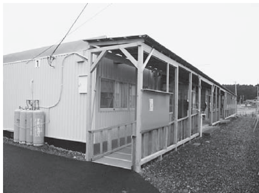
仮設住宅外観：砂利の上に建設され、駐車場はアスファルト敷きというのが一般的。手前は談話室で、スロープは一部の棟に設置されている。
