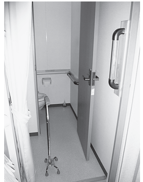
トイレ前：仮設住宅の構造上、風呂トイレへのアプローチには段差がある。手前の手すりは後付けのもの。
